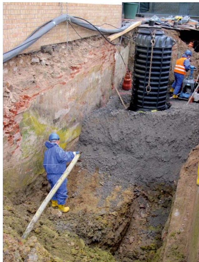
Abbildung 8: Bodenaustausch und Neuerrichtung der kompletten Infrastruktur
