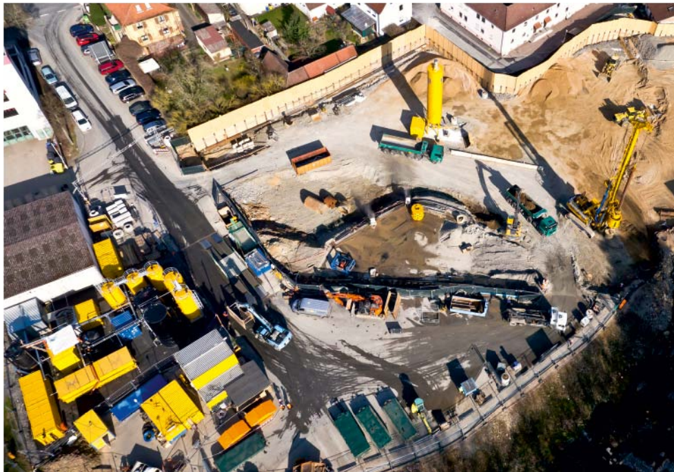
Abbildung 9: Hauptschaubereich, Bodenaustausch durch Großlochbohrungen, Lärmschutz für Anwohner, Wasserreinigungsanlage (mit freundlicher Genehmigung der Bauer Umwelt GmbH)
