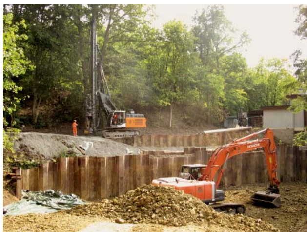
Abbildung 6: Ufersicherung im hochwassergefährdeten Bereich eines Schulgeländes während des laufenden Schulbetriebs
