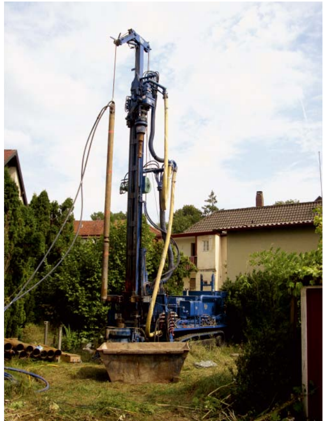
Abbildung 3: Sondierungsarbeiten im Rahmen der Sanierungsuntersuchung
