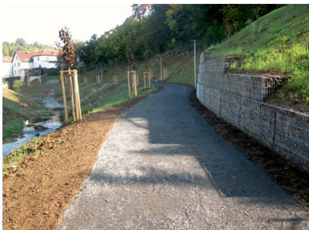
Abbildung 11: Neuer Geh- und Radweg entlang der Steinach
