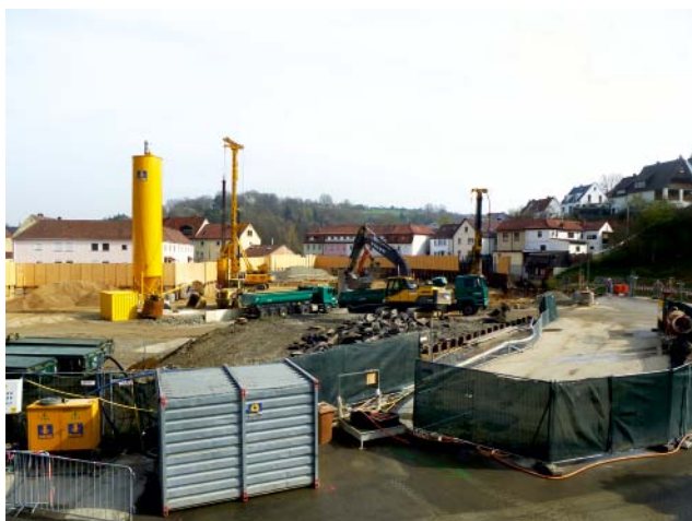
Abbildung 7: Bodenaustausch durch Großlochbohrungen im Hauptschadensbereich
